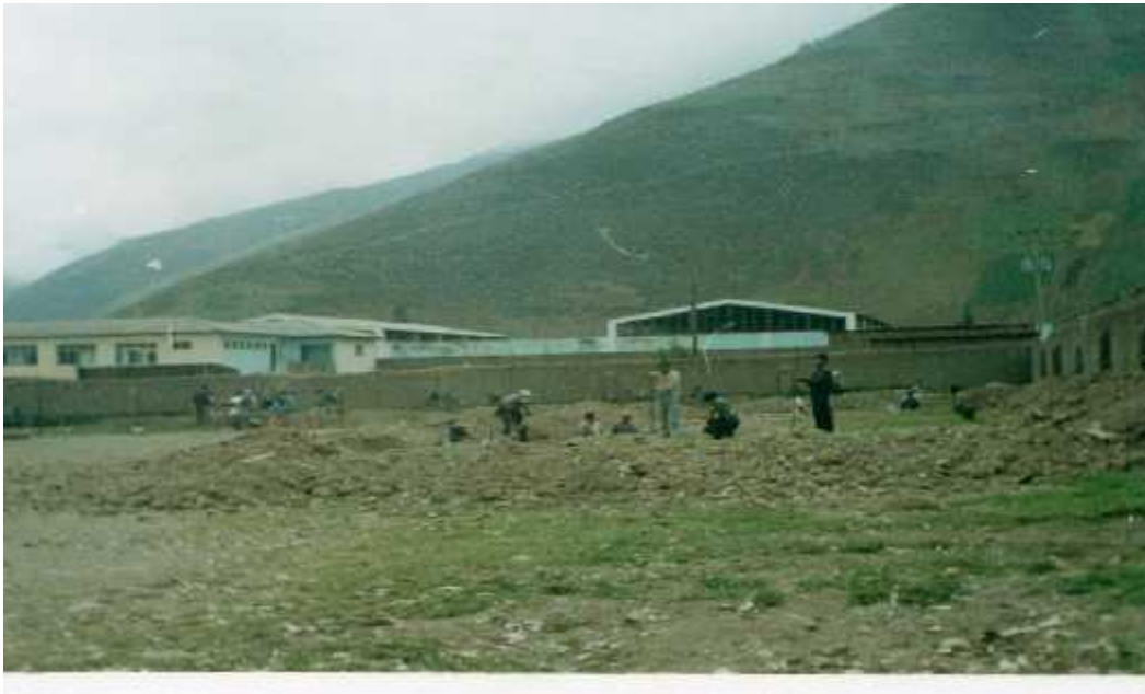
Padres de familia escavando zanja para la construcción de la escuela en el año 1992
