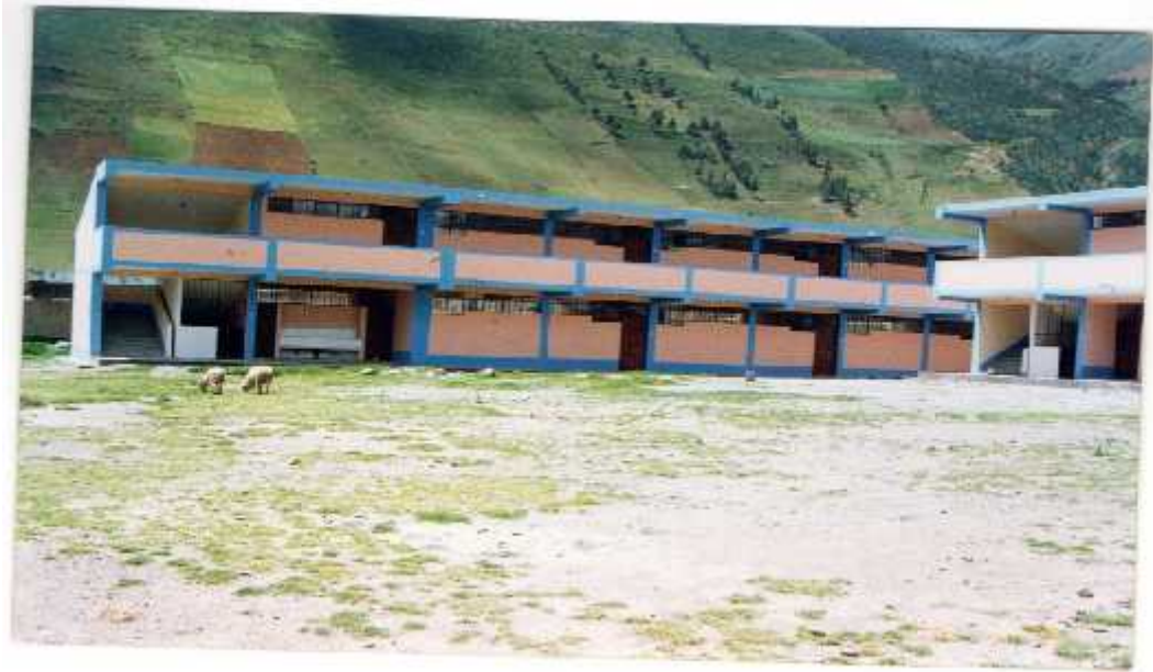
Obra entregada en el año 1996
